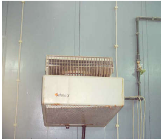
شكل (٤٧) جهاز رفع نسبة الرطوبة
