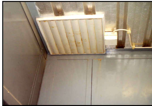
شكل (230) يوضح مروحة شفط الغاز في سقف غرفة التبخير
