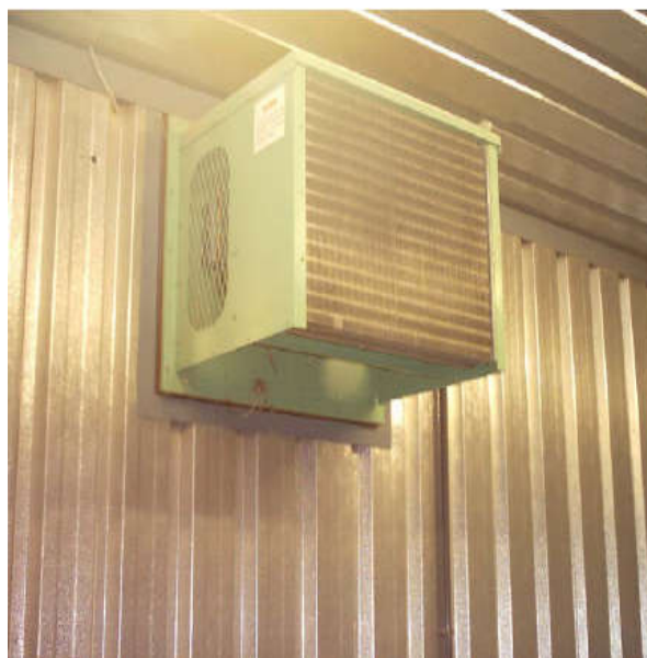
شكل (133) يوضح جهاز تكييف داخل غرفة حفظ البيض
