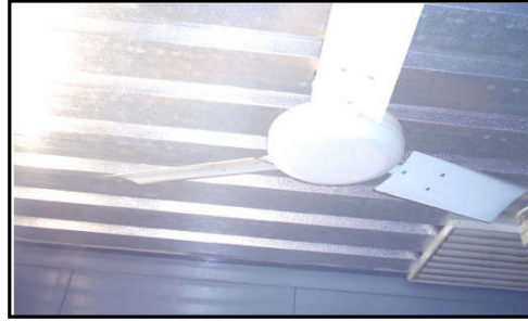
شكل (229) يوضح مروحة لتقلب الهواء وتوزيع غاز الفورمالدهيد على بيض التفريخ
