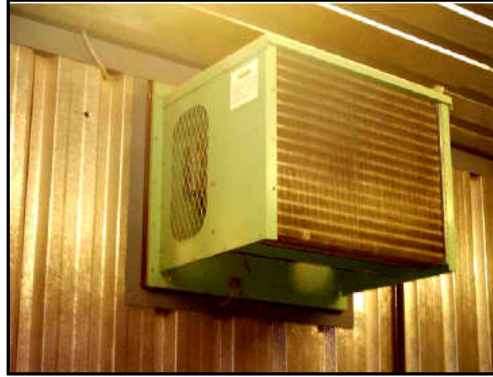
شكل (231) يوضح جهاز تكييف داخل غرفة حفظ البيض
