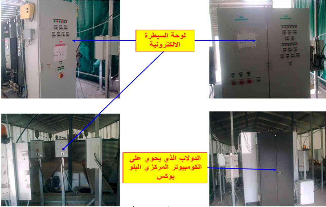
شكل يوضح لوحة السيطرة الألكترونية
